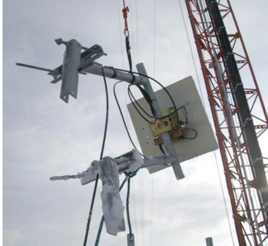
Figure 7.1: Une antenne avec un support d'entretoise étant élevée sur une tour
