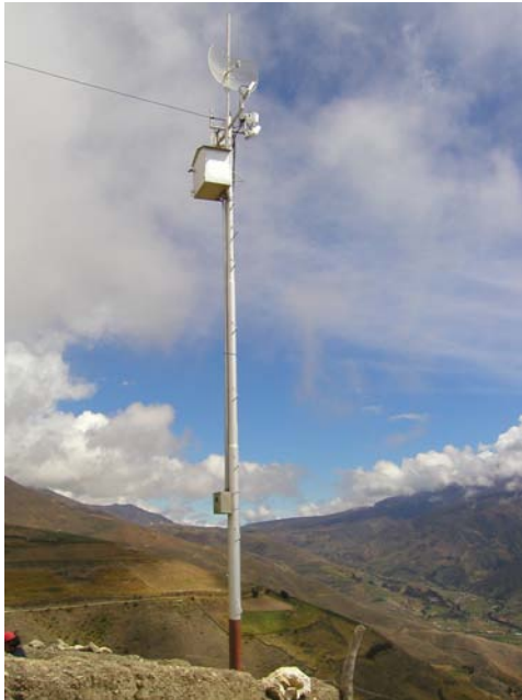
Figure 7.3: Une tour autoportante simple.
